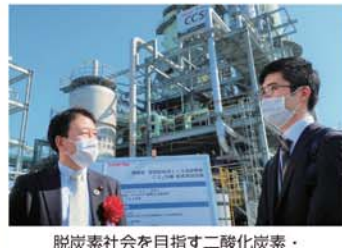
脱炭素社会を目指す二酸化炭素・分離回収設備竣工・起動手
